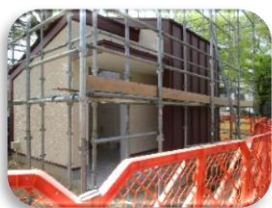
(大町公園トイレ改修中)
